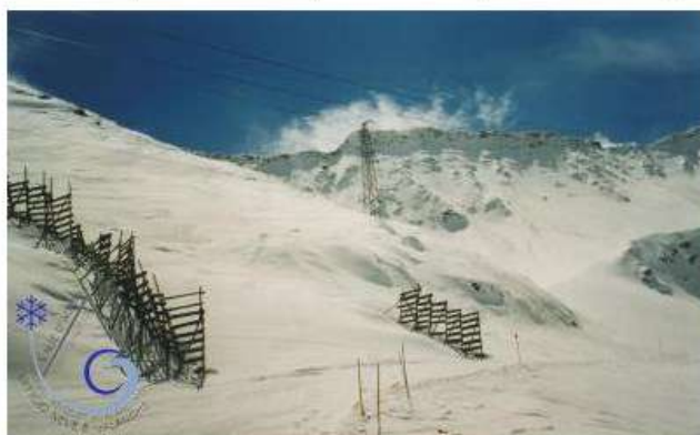
Ponti da neve posti a monte della pista da sci. Nell'aparte alta della fotografia si vede la zona di idstacco della valanga 60.
