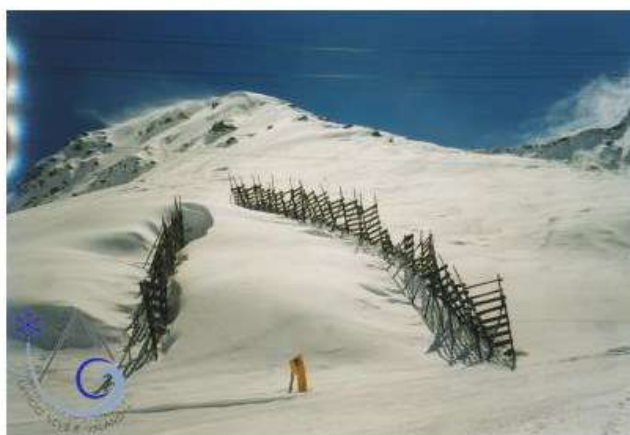
Ponti da neve posti a monte della pista da sci. Nell'aparte alta della fotografia si vede la zona di idstacco della valanga 62.
