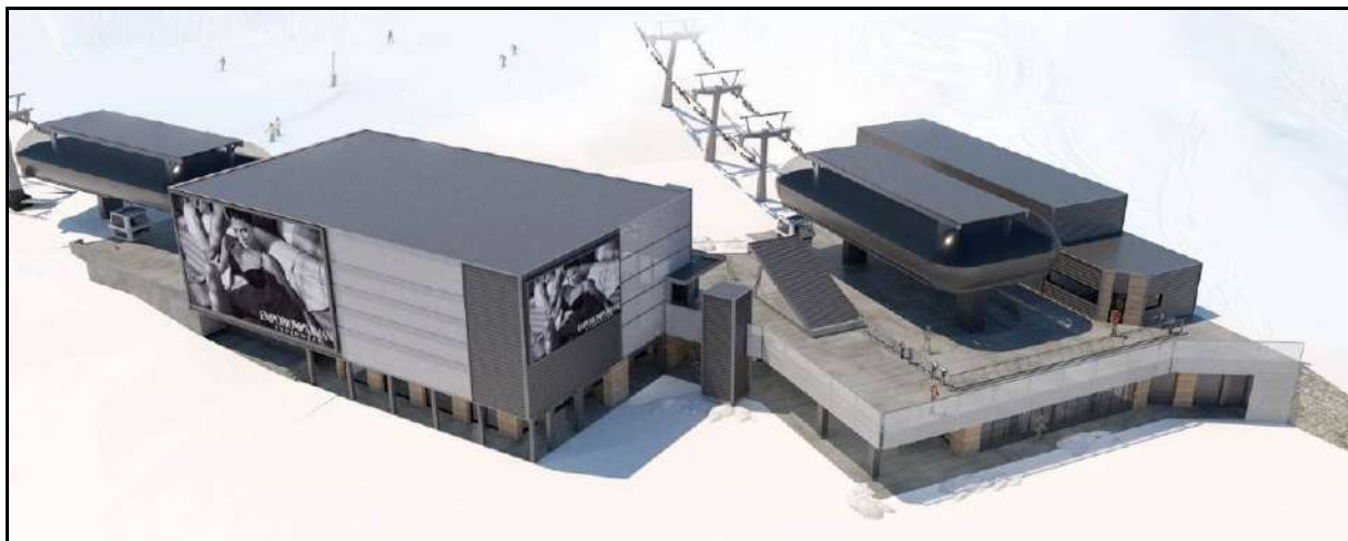
Assieme nuove stazioni funiviarie da punto di vista aereo
