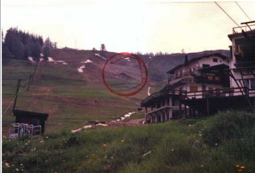
Fenomeno di frana avvenuta a monte di Plan Checrouit nell'ultima decade del maggio 1989. Essa è stata innescata da irrazionale distribuzione delle acque delle scoline della Pista di Coppa del Mondo.
