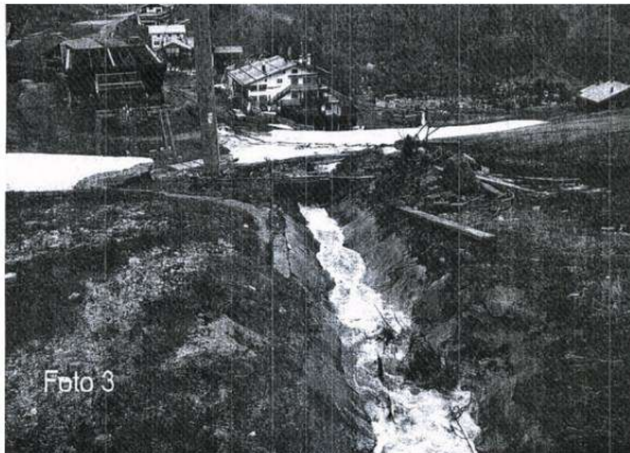
Canale di raccolta delle acque a servizio delle piste di Checrouit
